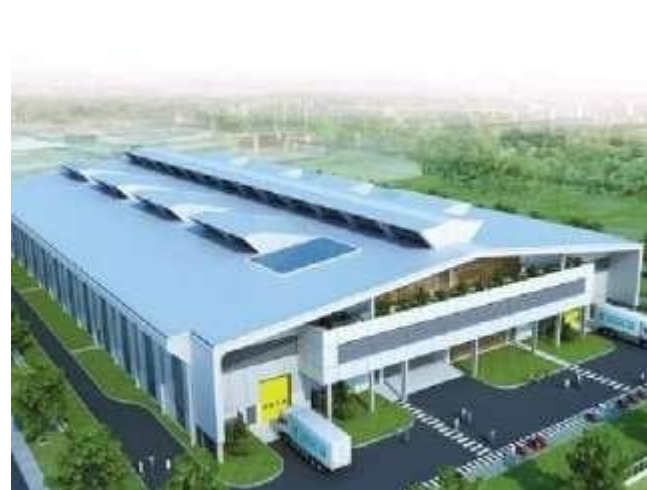
CÔNG TRÌNH NHÀ MÁY CÔNG NGHIỆP
