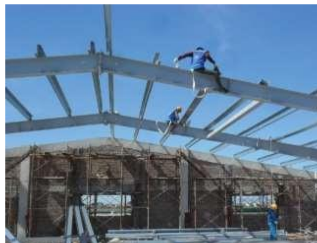
CÔNG TRÌNH NHÀ XƯỞNG
